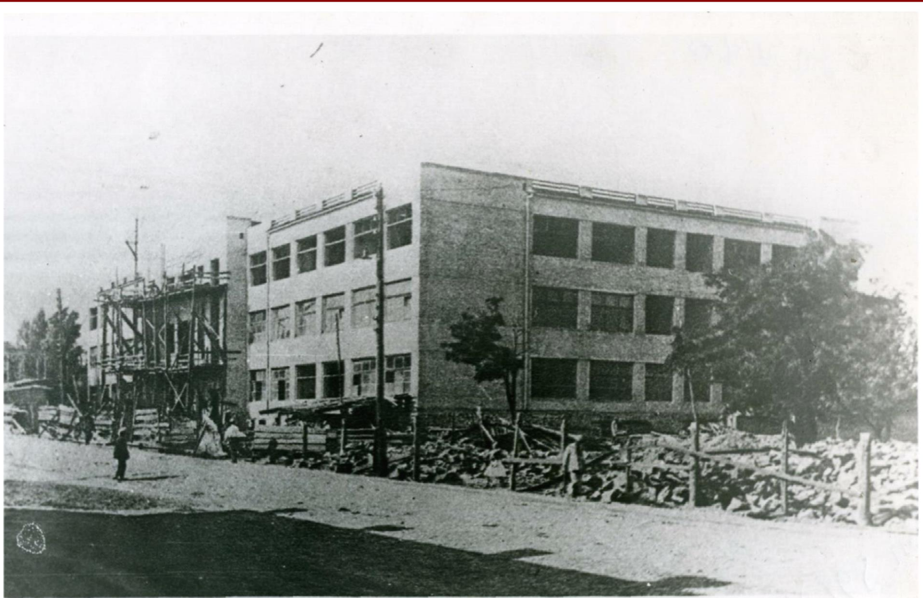
Строительство Рабфана в г. Шахтах
