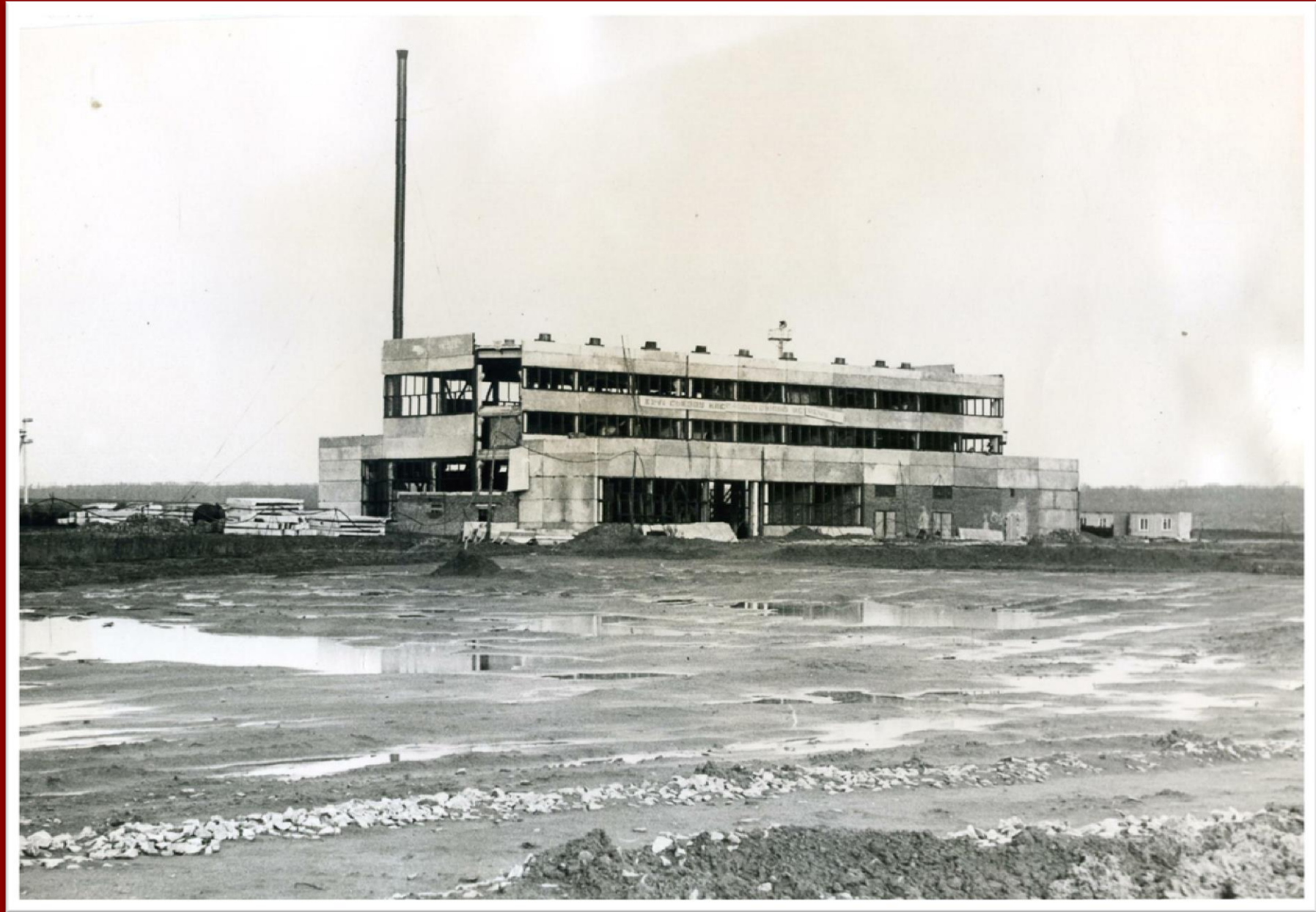
Строительство завода «Гидропривод»
